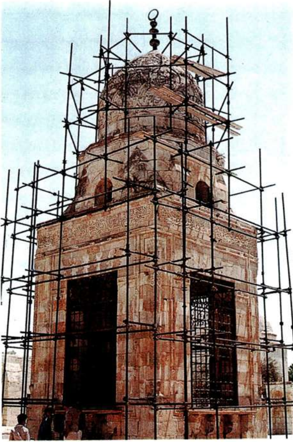
السبيل وحوله سقالات الترميم
